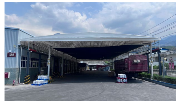
四川五丰黎红加装车间空调，改善员工作业环境，同时搭建装卸区活动遮雨棚，预防员工中暑
