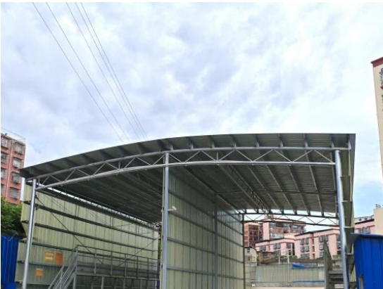
南宁五丰实施洗消中心改造后
