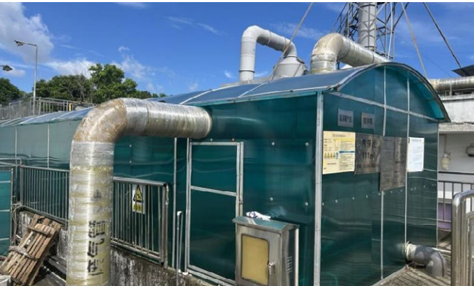
深圳五丰升级臭气治理设施
