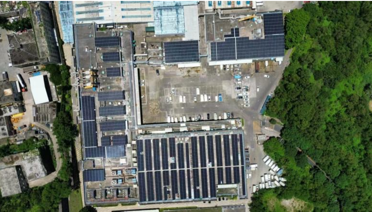
深圳五丰 1.35MWp 分布式光伏
