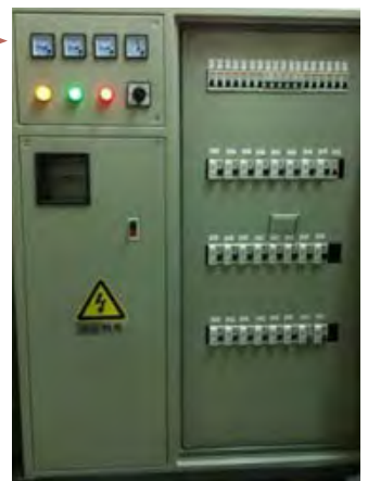
电柜更换后（开关都配有漏电防护）
